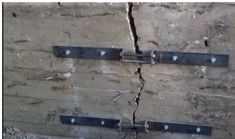
Figure 13 : Traitement de la fissure à l'aide d'une règle métallique
