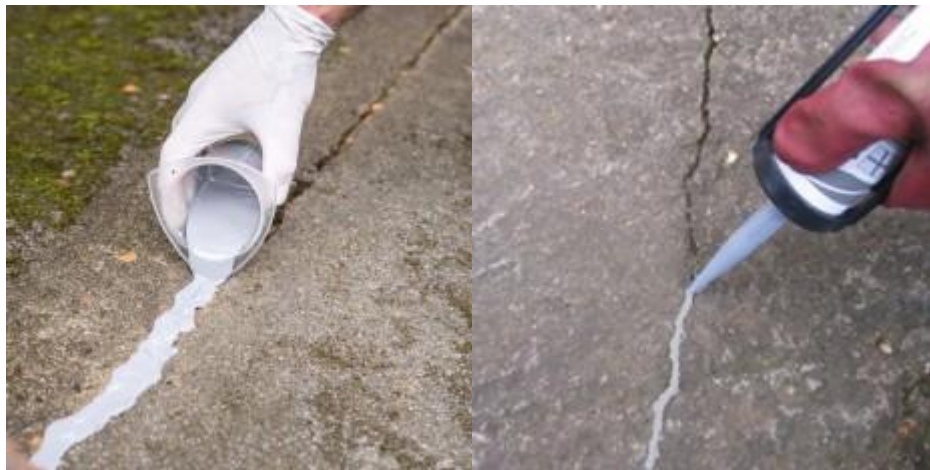
Figure 11 : Enduit de rebouchage liquide pour microfissures (à gauche) et résine de réparation pour fissure souple (à droite).
